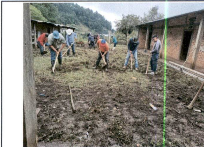
Foto1: Área donde se esta mejorando la losa de patio del establecimiento.
