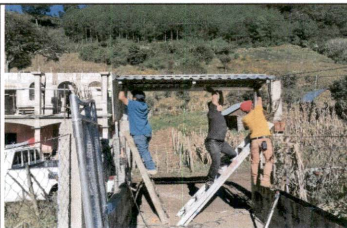
Foto 4: Se esta realizando la instalación del portón de ingreso al establecimiento y su techo protector.
