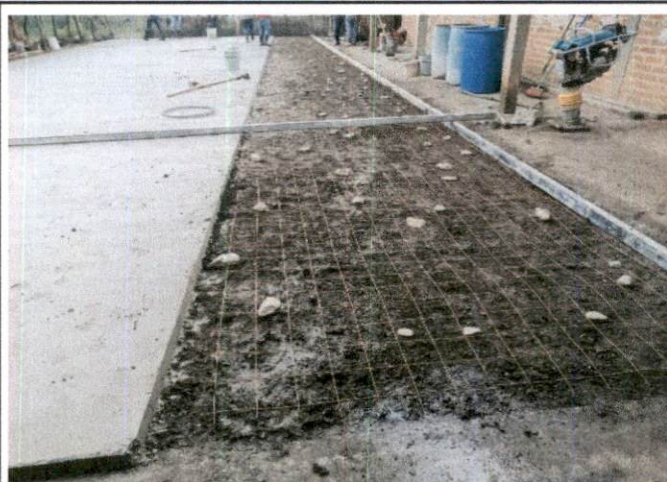
Foto 2: Mejoramiento de la losa de patio con instalación de electromallas.
